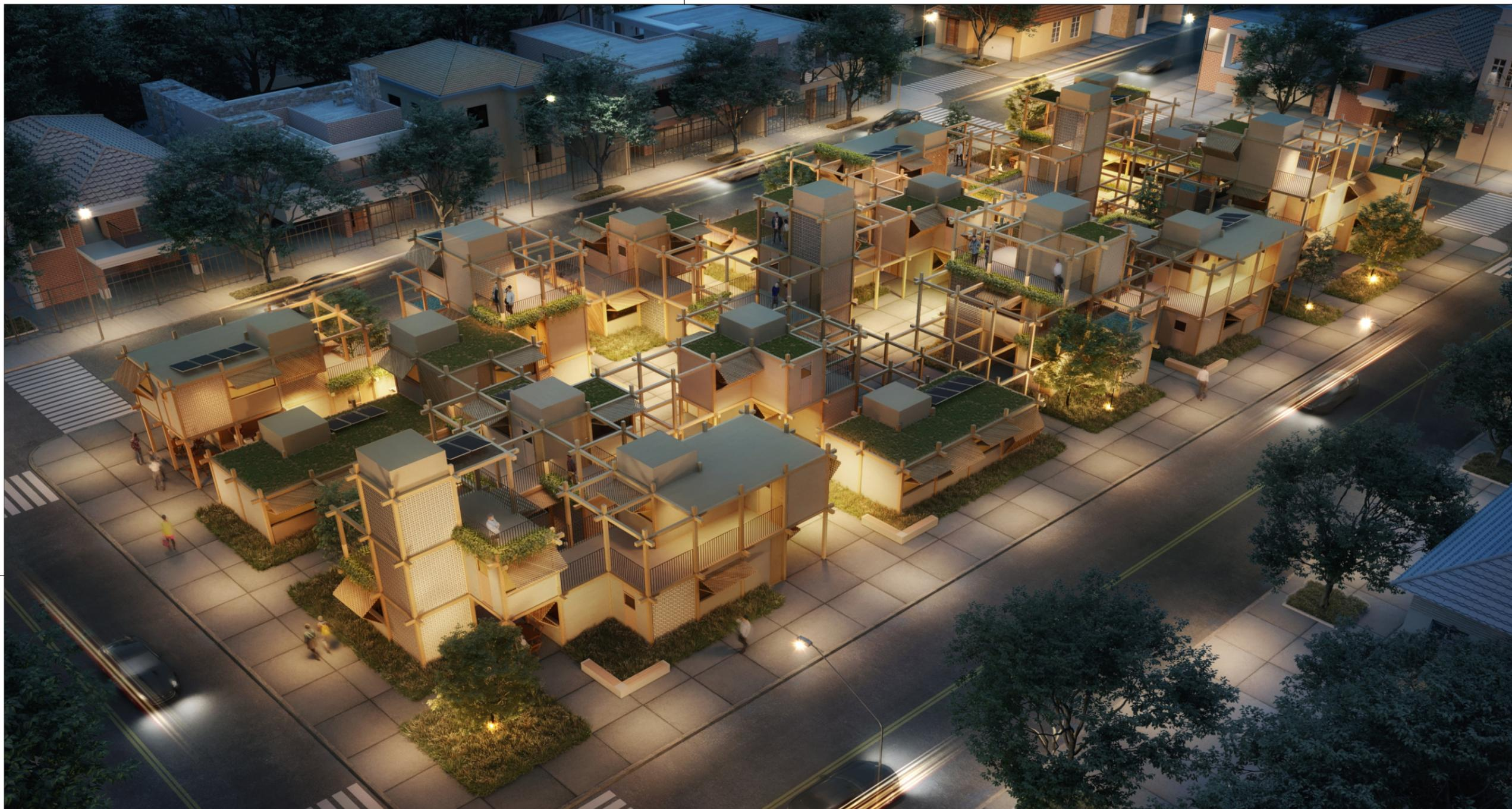
O projeto parte da medida primária da indústria brasileira – o módulo de 0,625m. Com isso se visa a redução de cortes e, conseqüentemente, sobras e desperdícios de materiais. Dessa forma, todos os componentes da construção – desde a estrutura até os acabamentos – podem ser encontrados pré-fabricados em todo o território nacional.
